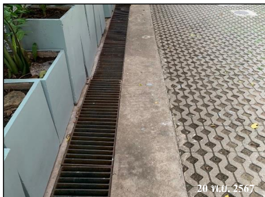
ภาพที่ 14 รางระบายน้ำภายในโครงการ
